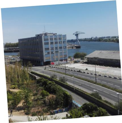
Ce bâtiment entre la Loire et la carrière misery est un héritage de l'industrie nantaise. Conçu en 1895 il fût le premier au monde construit avec le procédé Hennebique, soit par l'utilisation d'une structure en béton armé.
